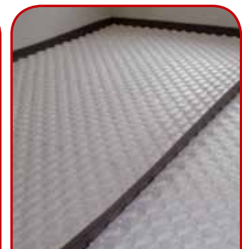
2 | POKLÁDKA SYSTÉMOVÝCH DESEK
