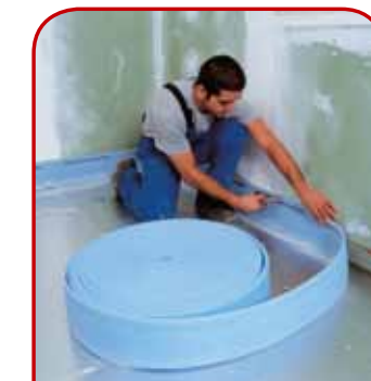
1 | UPEVNĚNÍ DILATAČNÍHO PÁSU
